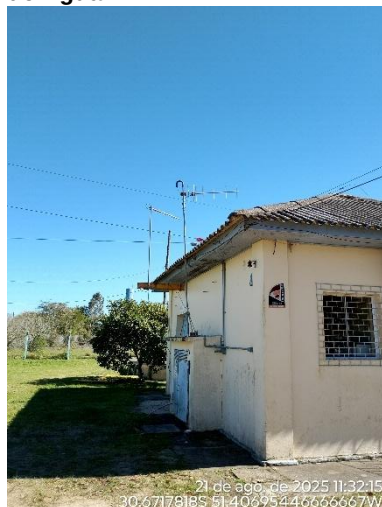
Figura 8: Estação de Tratamento de Água
