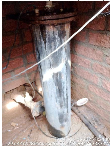
Figura 17: Motor Bomba 5m³/h e transdutor de pressão (EBA 01)
