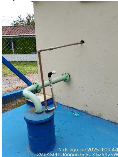
Figura 21: Captação subterrânea Poço RIO 01 (Motor Bomba 10m³/h)
