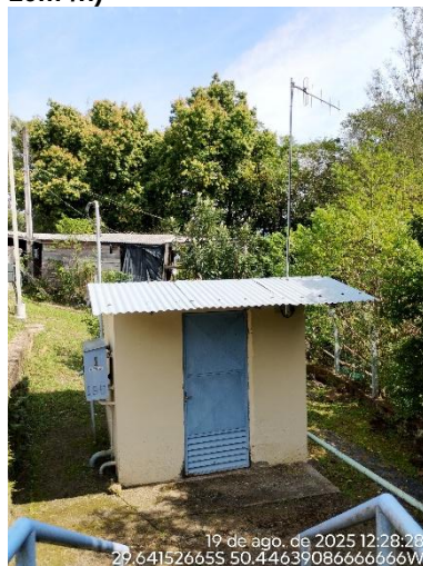
Figura 21: Captação subterrânea Poço RIO 01 (Motor Bomba 10m³/h)
