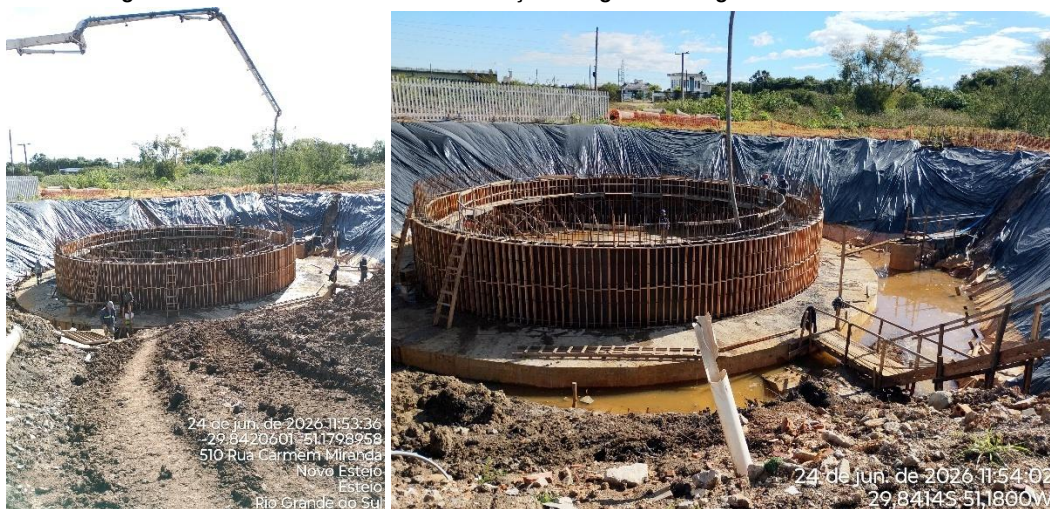
Figura 2 – Obras do sistema de recirculação da água de lavagem dos filtros
