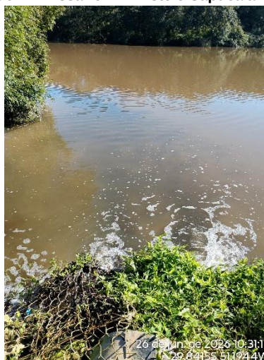
Figura 6 – Emissário ETE Esteio Sapucaia
