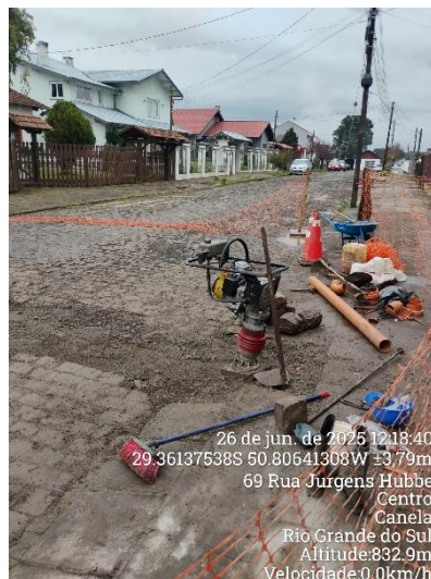
Ponto 02 – área com obra em andamento.
