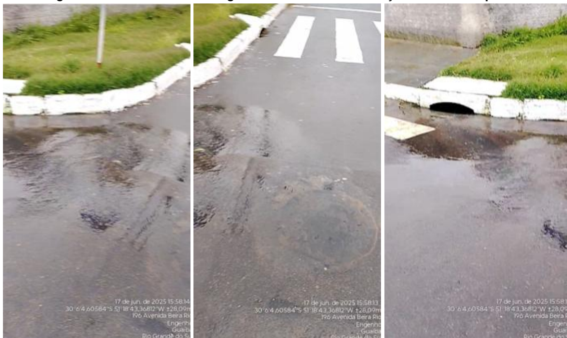
Figura 3 – Escoamento do esgoto extravasado em direção ao sistema pluvial.
