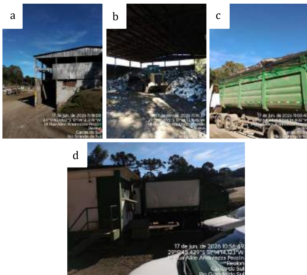
Figura 03: Unidade de transbordo de RSU de Caxias do Sul. a) Vista frontal da Unidade de Transbordo; b) Acompanhamento da transferência de resíduos para o caminhão de transporte; c) Transporte da unidade de Transbordo para a destinação final e d) Processo de pesagem de veículo de coleta a descarregar na Unidade de Transbordo.
