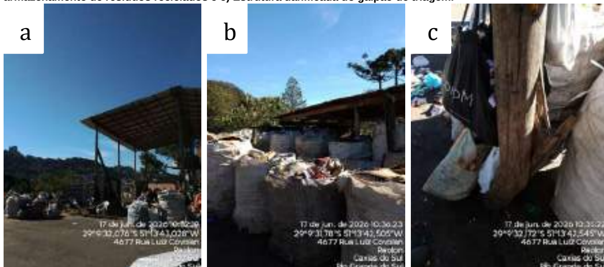
Figura 10: Central de Triagem União dos Catadores. a) Visão geral do galpão de triagem; b) Visão geral do armazenamento de resíduos reciclados e c) Estrutura danificada do galpão de triagem.
