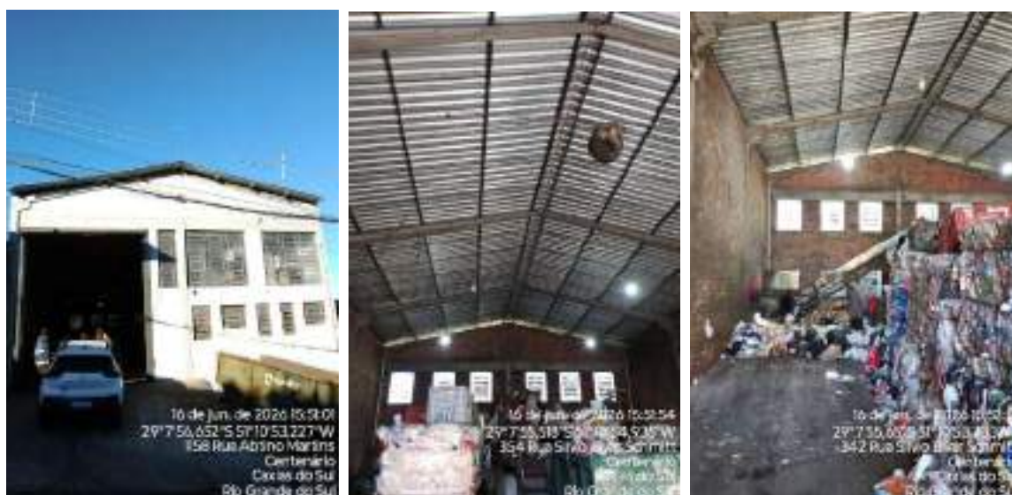
Figura 13: Central de Triagem Centenário.
