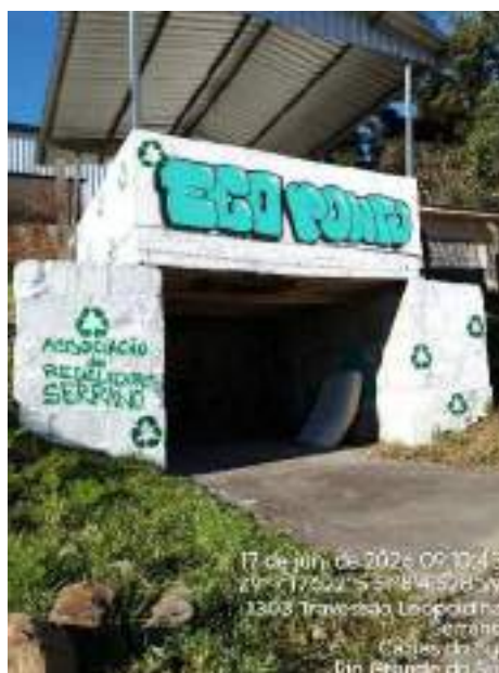
Figura 25: Ecoponto em obras.
