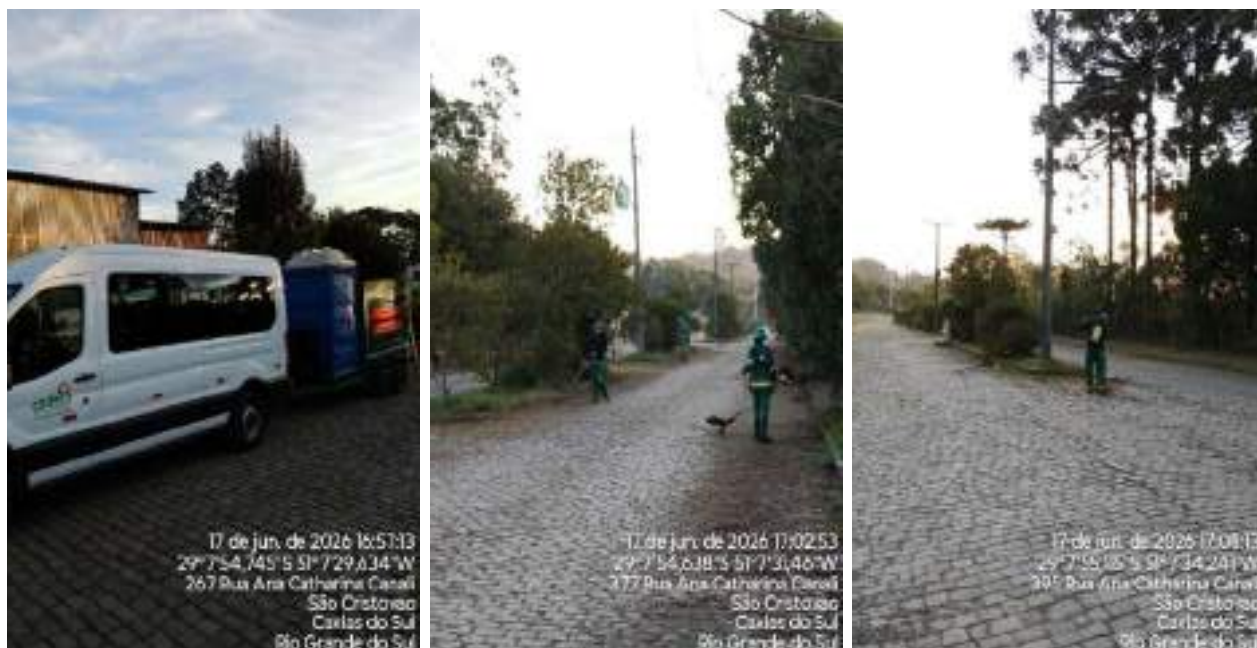
Figura 20: Atividade de capina em andamento.
