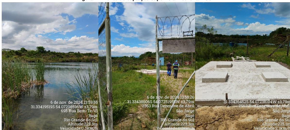
Figura 1 – Ponto de captação superficial Pedreira IFSUL.
