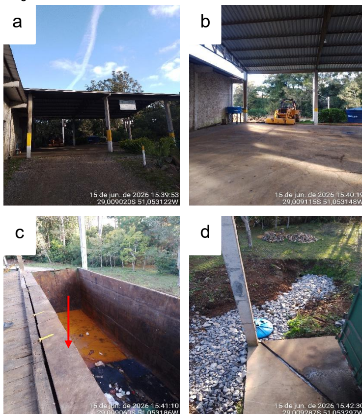
Figura 08: Identificação na unidade do transbordo. a) vista frontal do transbordo; b) vista interna da área de transbordo; c) caçamba do caminhão transportador e melhoria na rampa de inserção de rejeitos na unidade (seta vermelha) e d) calha de drenagem de chorume.
