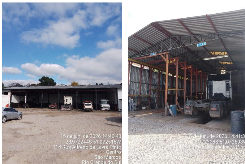
Figura 10: local de estacionamento e manutenção de veículos da empresa Daros em São Marcos.
