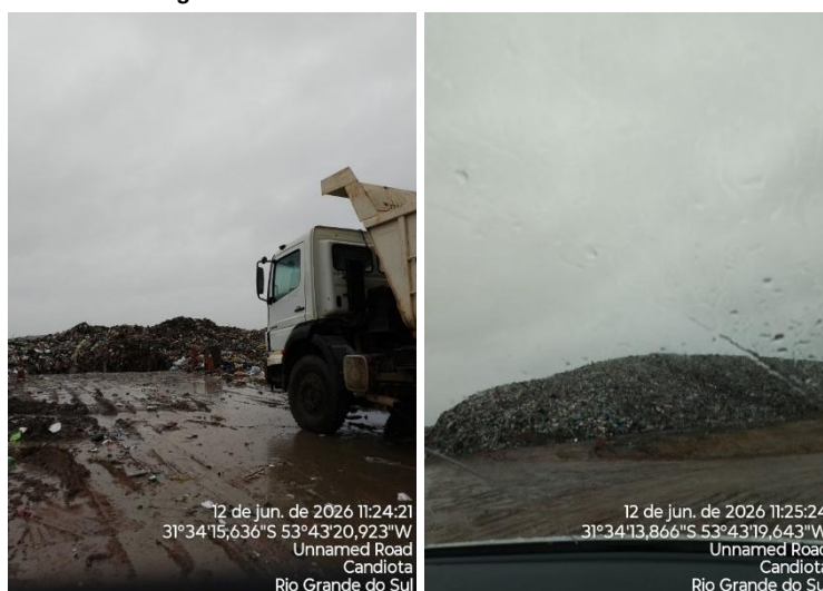
Figura 06: Descarregamento dos RSU na célula 02 do aterro sanitário e vista de célula 02.
