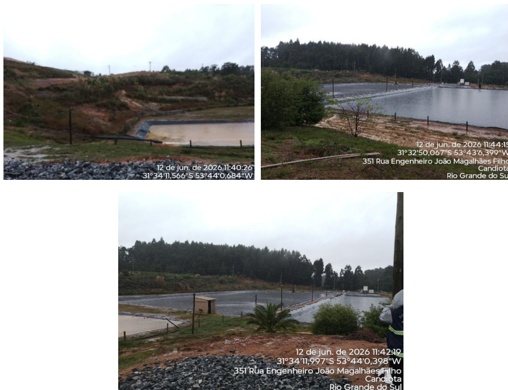
Figura 08: Lagoas de tratamento de lixiviado
