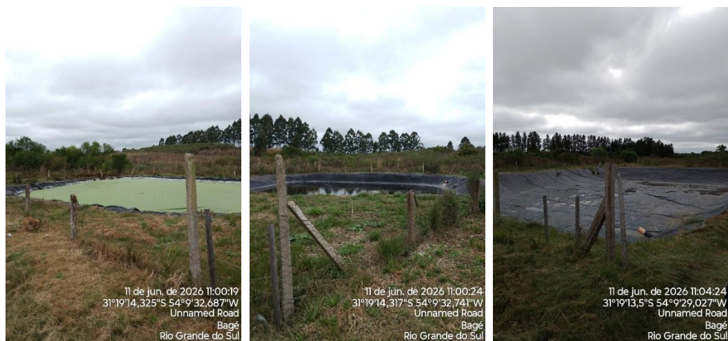
Figura 17: Leito de secagem extravasando
