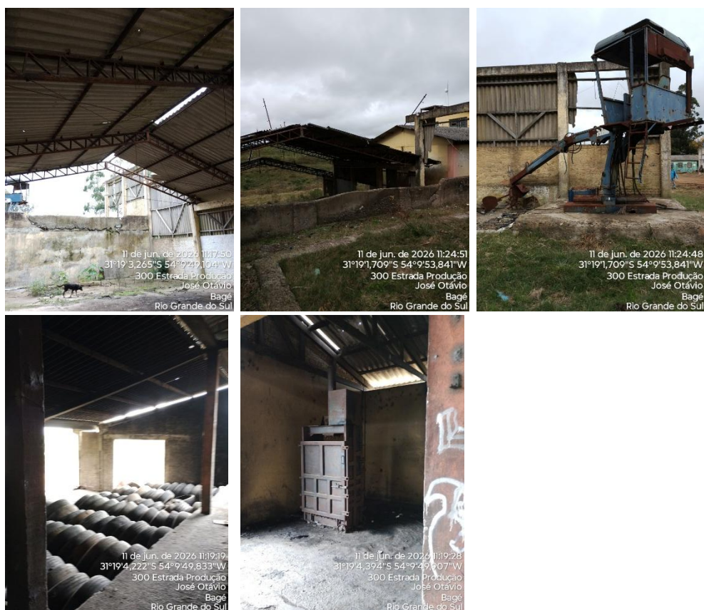
Figura 11: Identificação de galpão desativado com pneus inservíveis armazenados.
