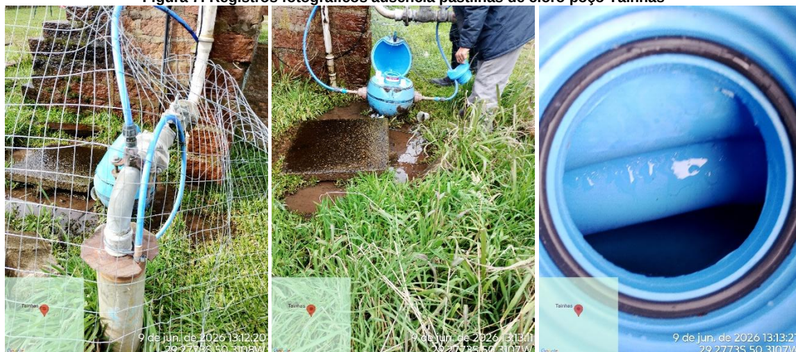
Figura 7: Registros fotográficos ausência pastilhas de cloro poço Tainhas
