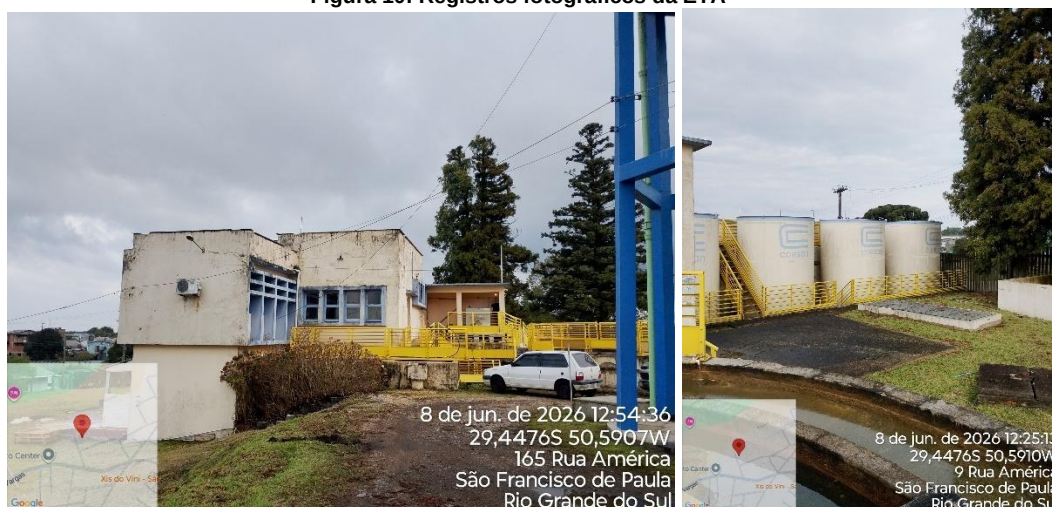
Figura 10: Registros fotográficos da ETA
