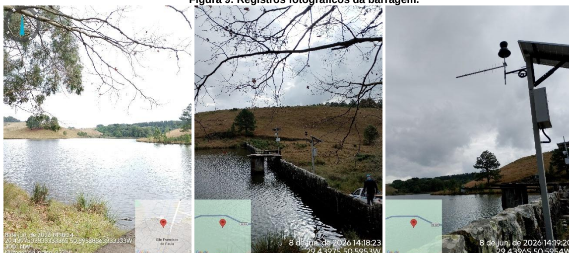
Figura 9: Registros fotográficos da barragem.
