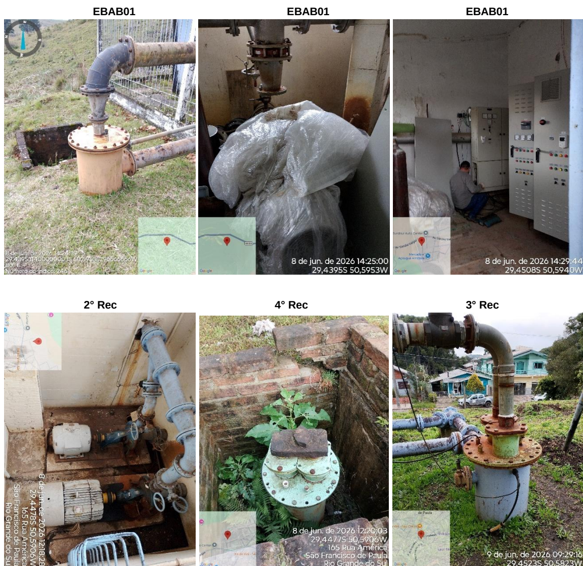
Figura 12: Registros fotográficos das elevatórias fiscalizadas.
