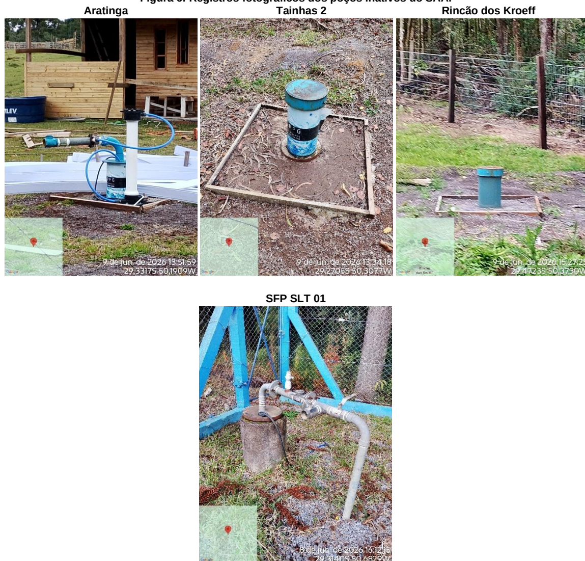
Figura 6: Registros fotográficos dos poços inativos do SAA.
