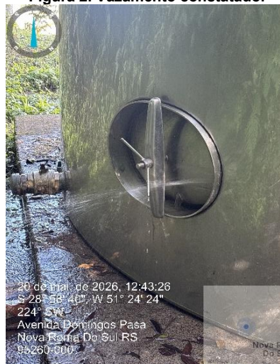
Figura 2. Vazamento constatado.
