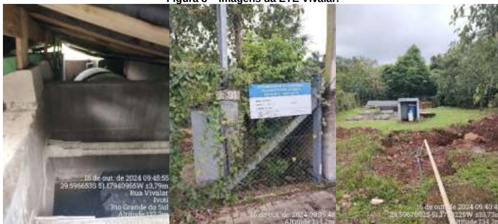
Figura 8 – Imagens da ETE Vivalar.
