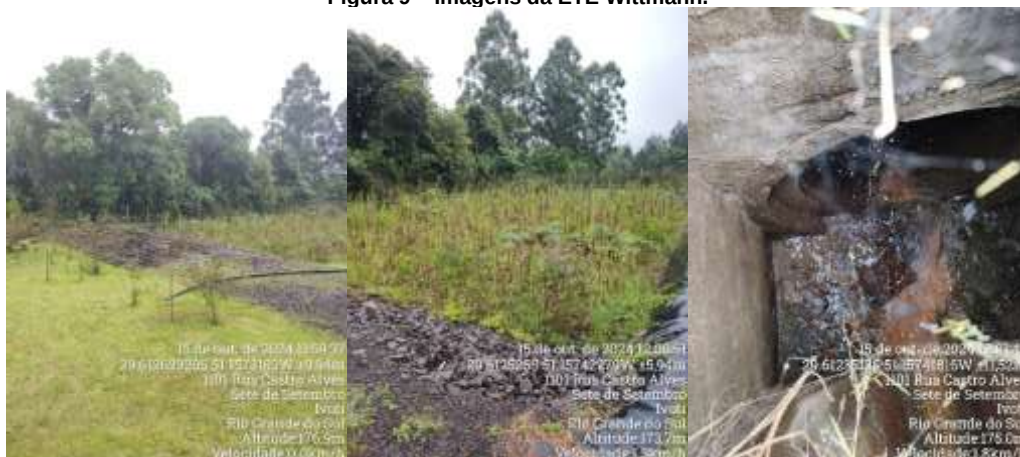
Figura 9 – Imagens da ETE Wittmann.
