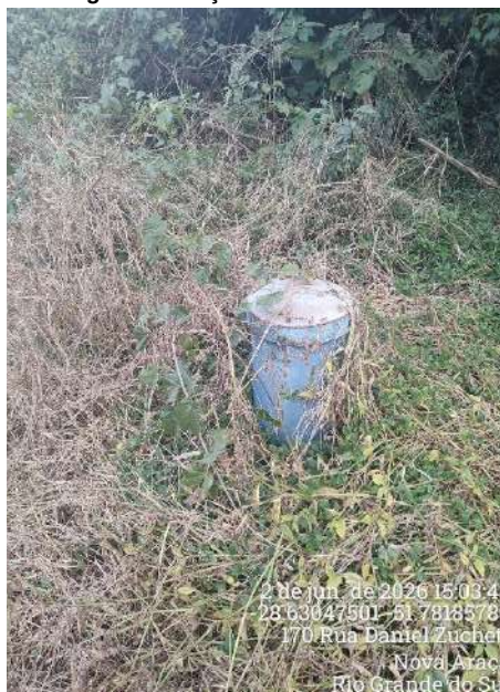
Figura 1 - Poço desativado PRI 32.
