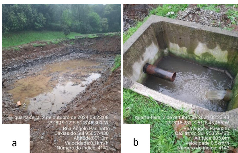
Figura 02: Estruturas removidas da ETE Dal Bó. a) estrutura removida da ETE Dal Bó; b) Desvio da vazão de entrada para a ETE Tega.
