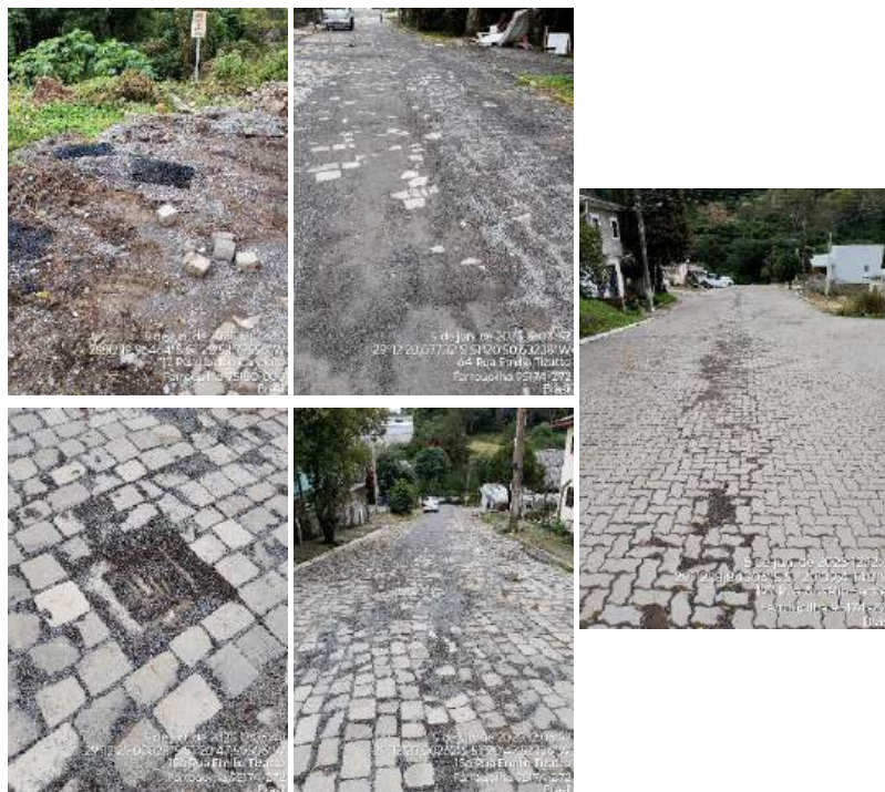
Figura 3- Registro fotográfico Rua Emílio Tizzato
