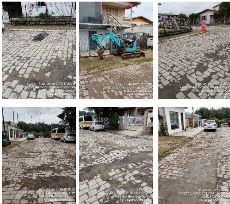
Figura 7 – Registro fotográfico Rua Cândido Cauã.
