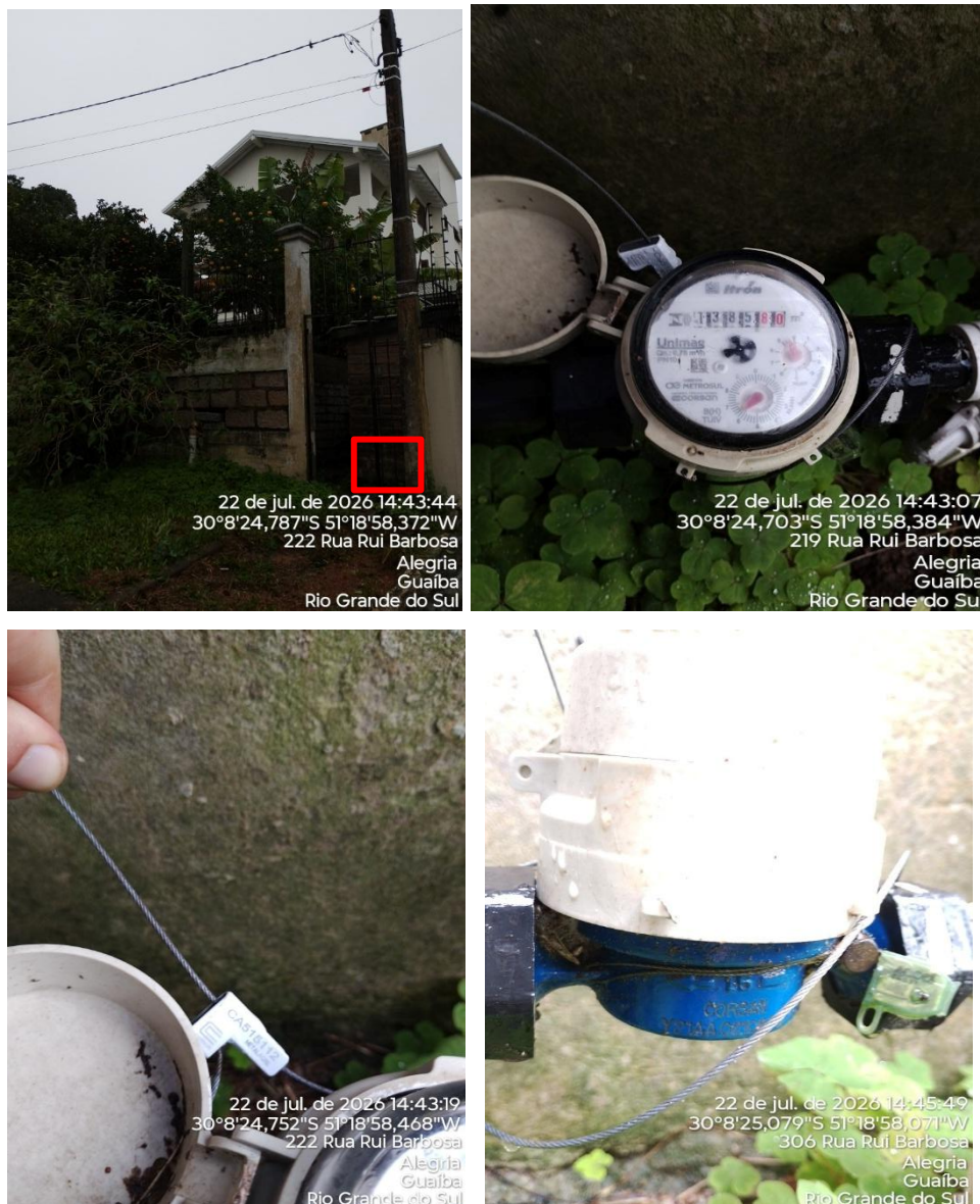
Figura 02: Vista frontal do imóvel e hidrômetro do imóvel.
