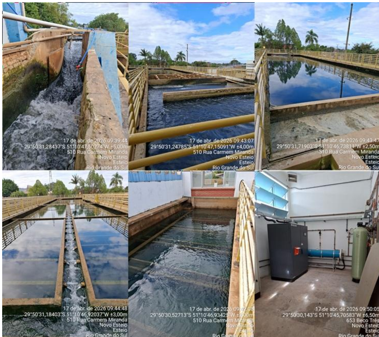
Figura 02: Registro das estruturas da ETA.
