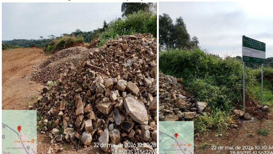
Figura 5: Área de disposição de resíduos de RCC
