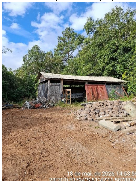
Figura 5: Área utilizada para a destinação pneus e sucata
