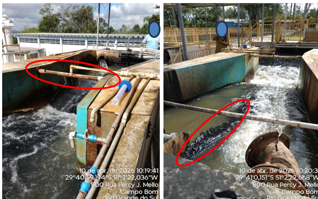
Figura 01: Identificação da entrada de água bruta na ETA de Campo Bom/RS.
