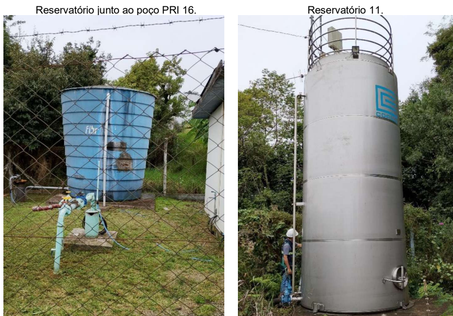
Figura 3 – Reservatórios não informados no Anexo II.
