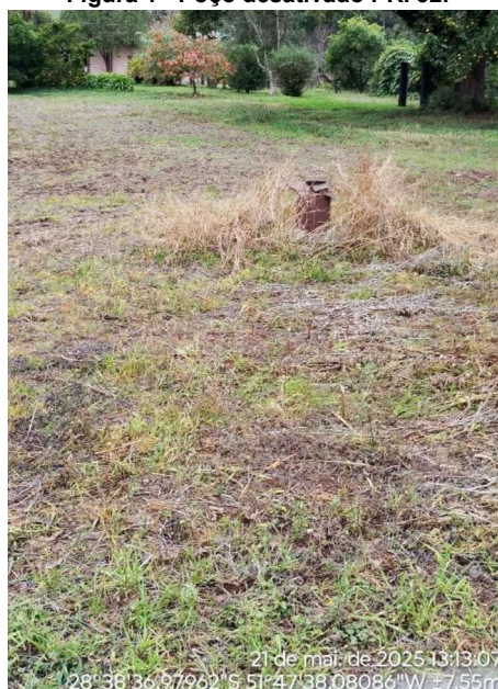
Figura 1 - Poço desativado PRI 32.
