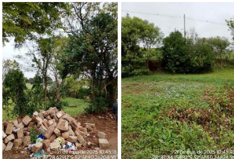
Figura 02: Estação de Tratamento de Esgoto em Tapera/RS.
