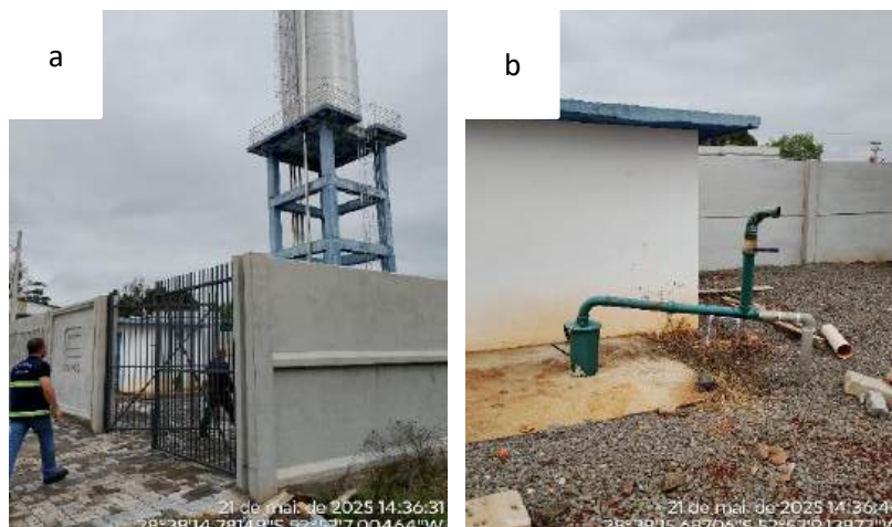
Figura 01: Reservatório novo em Tapera/RS. a) reservatório novo; b) poço localizado na estrutura.
