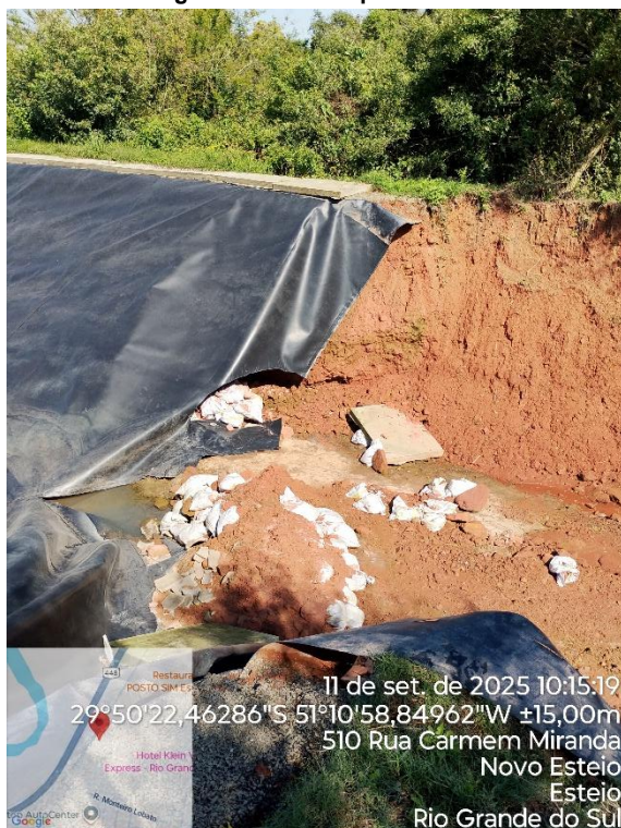
Figura 5 - Barreira provisória.
