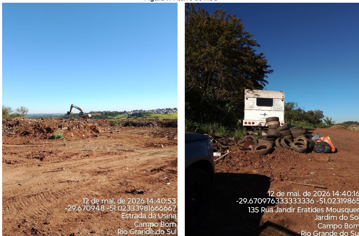
Figura 7: Aterro de RCC
