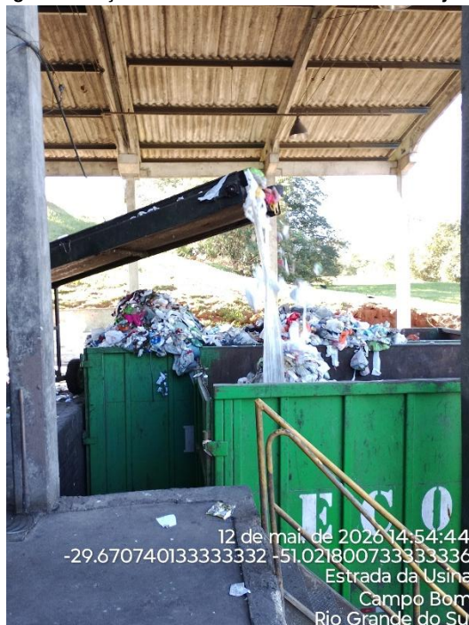
Figura 5: Caçamba utilizada no transbordo dos rejeitos
