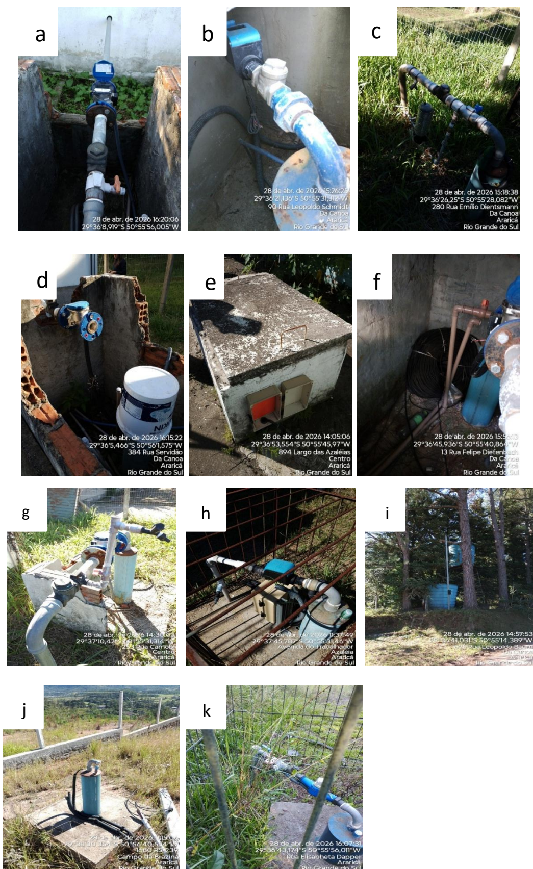
Figura 03: Identificação dos poços existentes em Araricá/RS. a) poço 01; b) poço 02; c) poço 03; d) poço 04; e) poço 05; f) poço 06; g) poço 07; h) poço 08; i) poço 09; j) poço 10 e k) poço 11.
