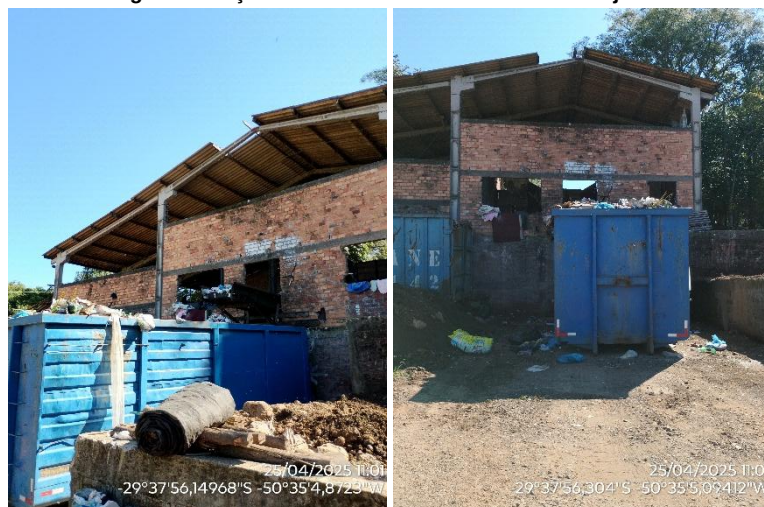
Figura 5: Caçamba utilizada no transbordo dos rejeitos
