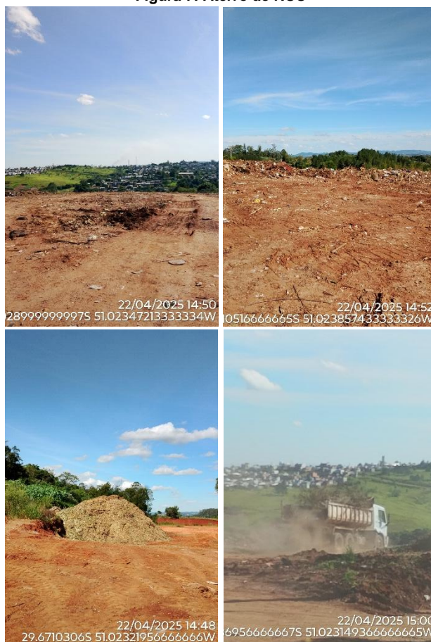
Figura 7: Aterro de RCC
