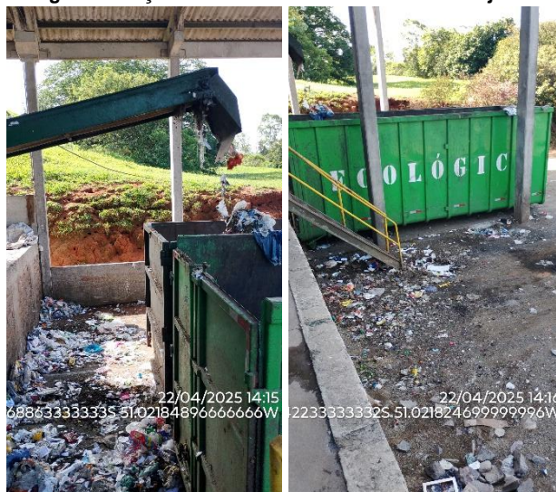
Figura 5: Caçamba utilizada no transbordo dos rejeitos
