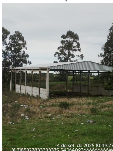
Figura 8: Pavilhão em obras para transbordo de RSU
