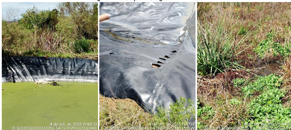
Figura 15: Situação das lagoas de lixiviado
