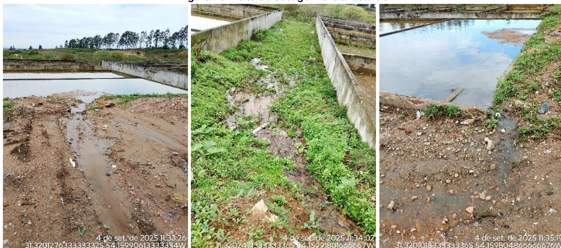
Figura 16: Leito de secagem extravasando
