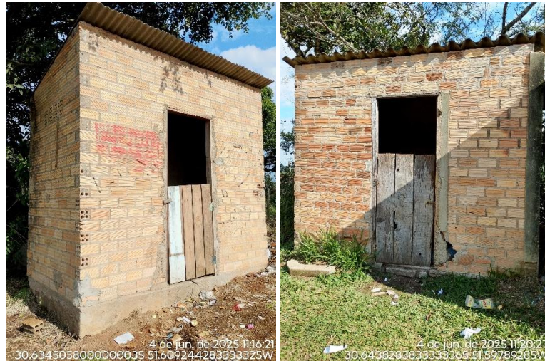
Figura 2: Locais de acondicionamento de RSU na zona rural
