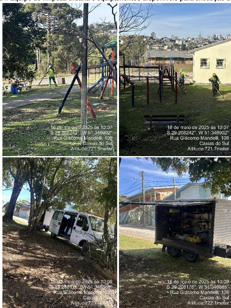
Figura 14: Equipe de limpeza urbana e equipamentos disponíveis para execução do serviço
