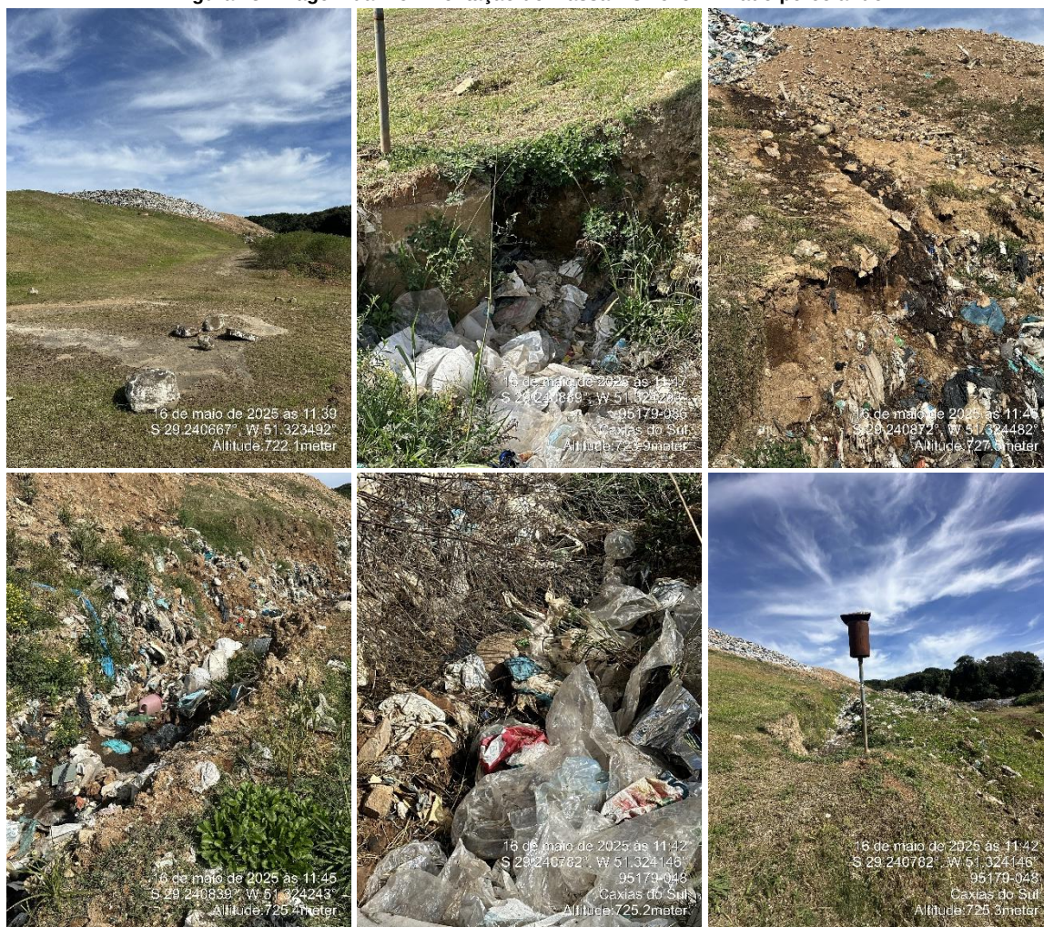
Figura 13: Imagem da movimentação de massa visível e lixiviado percolando
