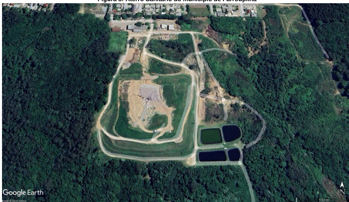
Figura 8: Aterro Sanitário do município de Farroupilha
