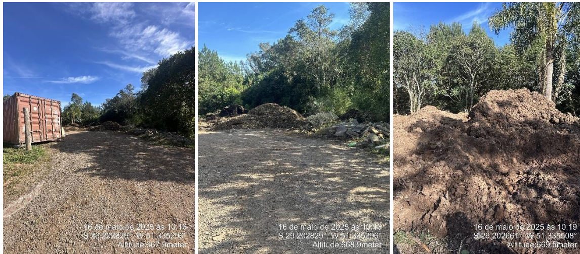
Figura 16: Local de disposição de resíduos de poda
