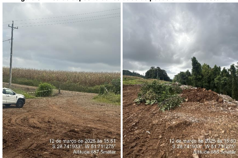
Figura 3: Área de depósito de resíduos de podas em Nova Bassano
