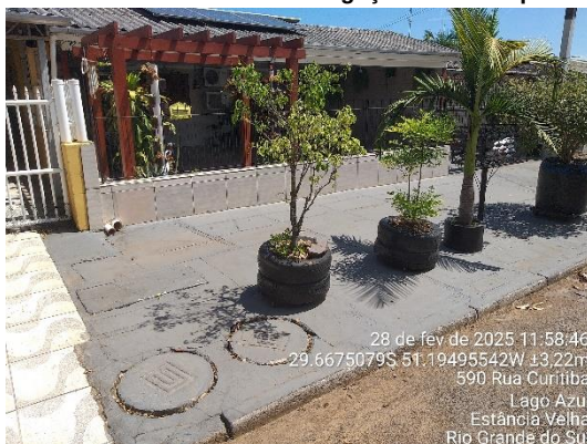
Figura 2 - Registro fotográfico da evidência de caixa de ligação: Vista da parte frontal do imóvel.
