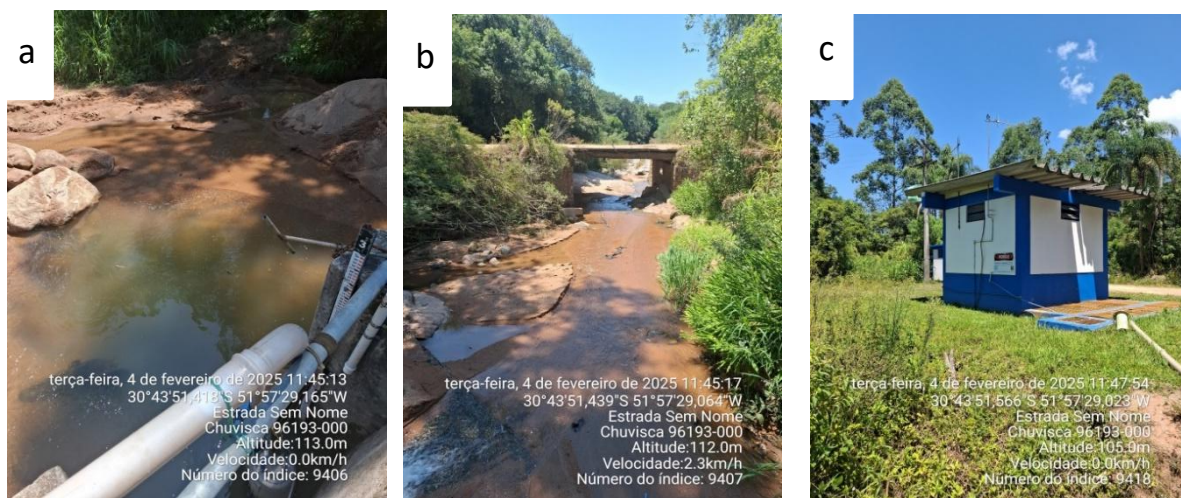
Figura 1: Barragem de captação de água do Arroio Joaquim Martim. a) Vista do ponto de captação de água bruta; b) Visão geral do Arroio Joaquim Martim; c) Estação de bombeamento de água bruta, com estruturas de desarenação.
