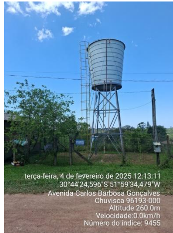
Figura 03: Reservatório R-03 substituído.
