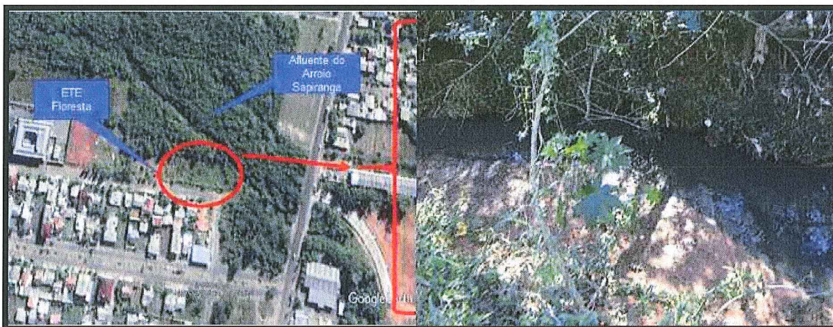
Figura 6: Localização espacial da ETE Floresta, nas coordenadas geográficas 29°39'41.89S, 51°00'05.39O e a vista do afluente do Arroio Sapiranga. Fonte: disponível no Google Earth, acesso em 2º de julho de 2020.
