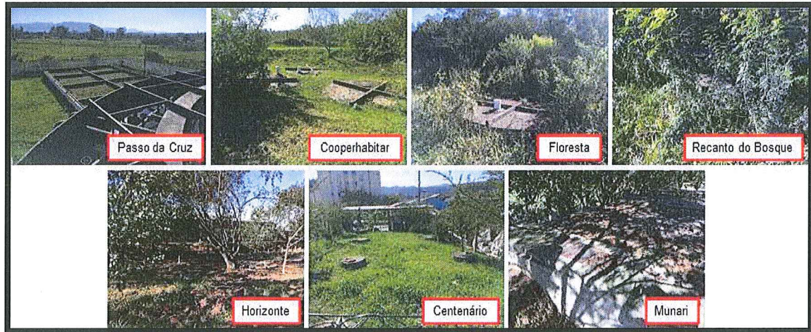
Figura 3: Vistas das Estações de Tratamento de Esgoto.
