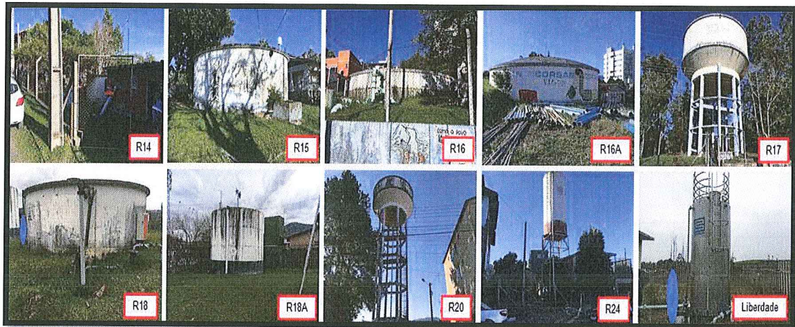
Figura 12: Vista dos Reservatórios Fiscalizados
