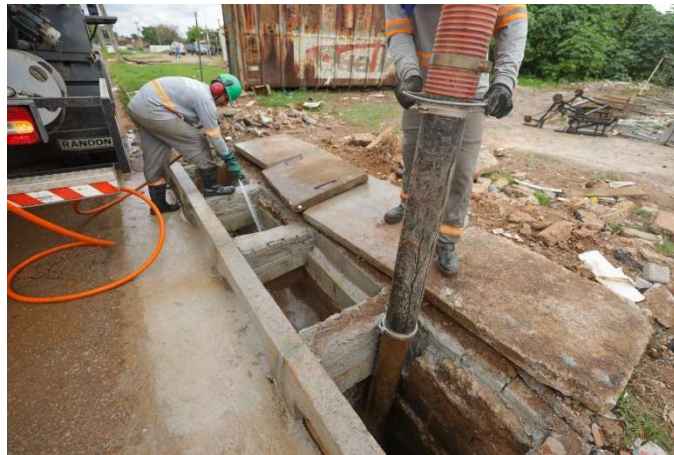
Figura 62 – Manutenção preventiva nas redes pluviais.
