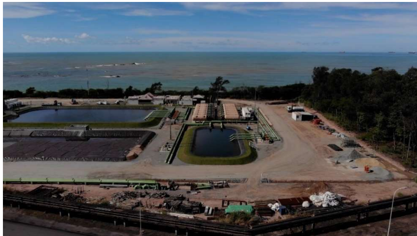
Figura 67 – Estação de Tratamento de Águas Pluviais.
