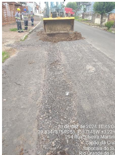
Figura 2 - Retro com serviços de abertura de vala.
