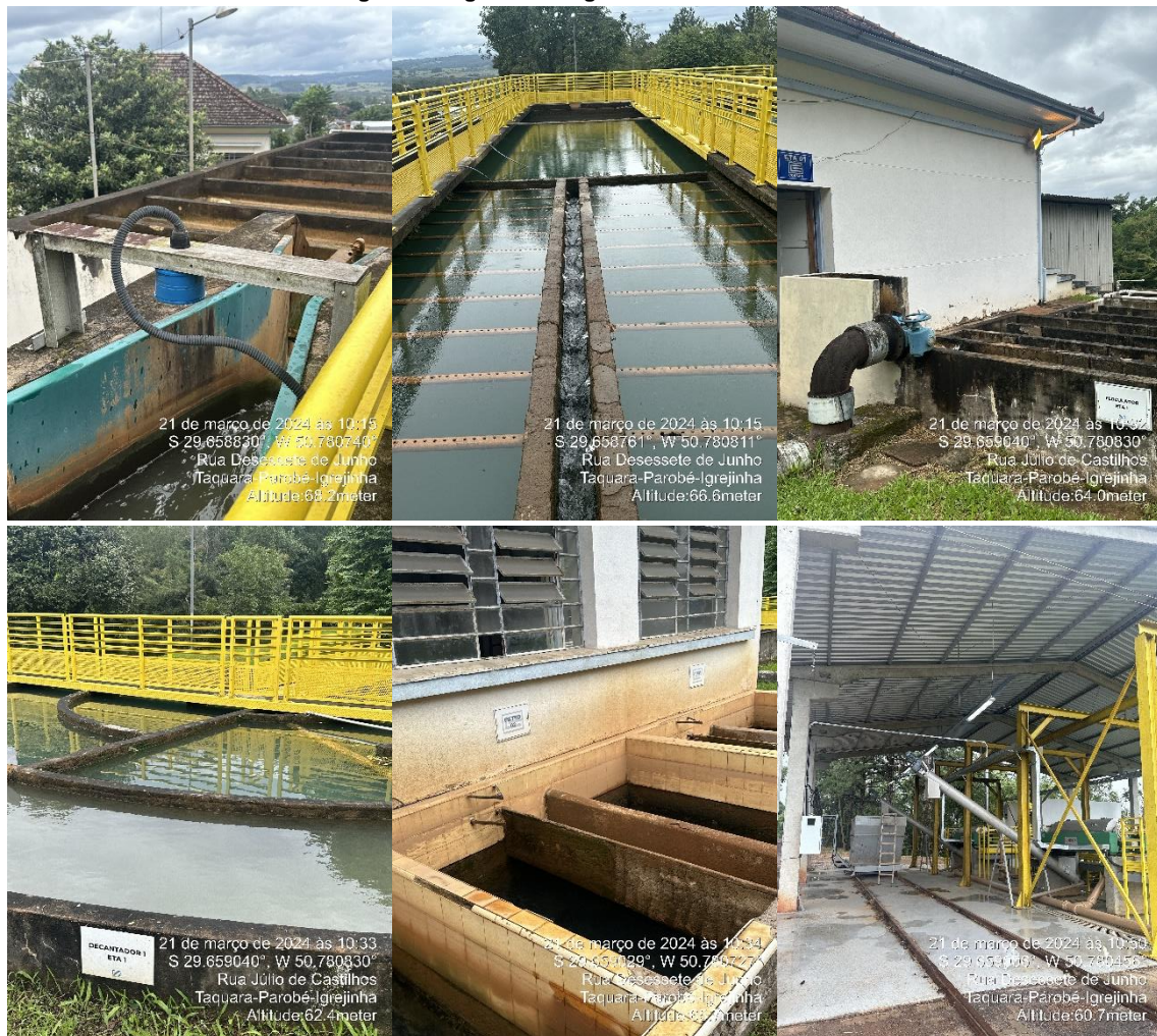
Figura 5: Registros fotográficos das estruturas da ETA.
