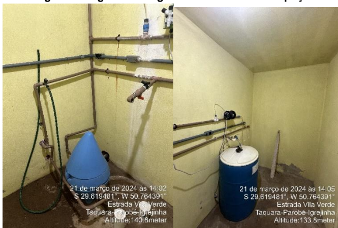
Figura 8: Registros fotográficos da estrutura do poço
