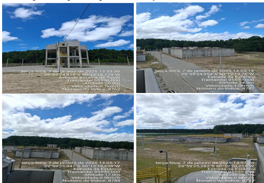
Figura 7 – Registro fotográfico das condições atuais da ETE Convencional.
