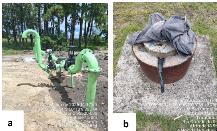
Figura 3 – Poços em Tramandaí/RS fora de operação. a) Poço OSO-14 na área da captação superficial, o qual irá entrar em operação; b) Poço junto ao reservatório R-08, o qual está desativado.
