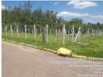
Figura 8 - Cercamento da ETE 01. Coordenadas Geográficas: 29°36'36.58" S 50°55'31.36" W
