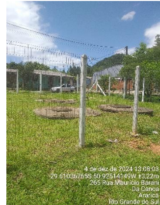
Figura 10 - Fossas da ETE 01 Coordenadas Geográficas: 29°36'37.32" S 50°55'30.51" W
