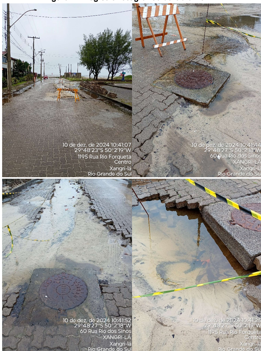
Figura 2 - Registro fotográfico da obra no PV.
