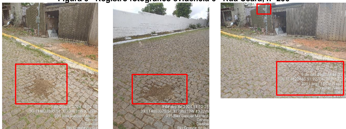
Figura 6 - Registro fotográfico evidência 6 - Rua Ceará, nº 296
