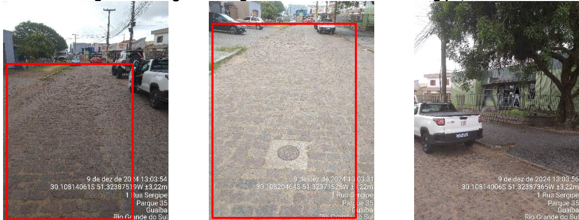
Figura 20 - Registro fotográfico evidência 20 - Rua Sergipe, nº 55
