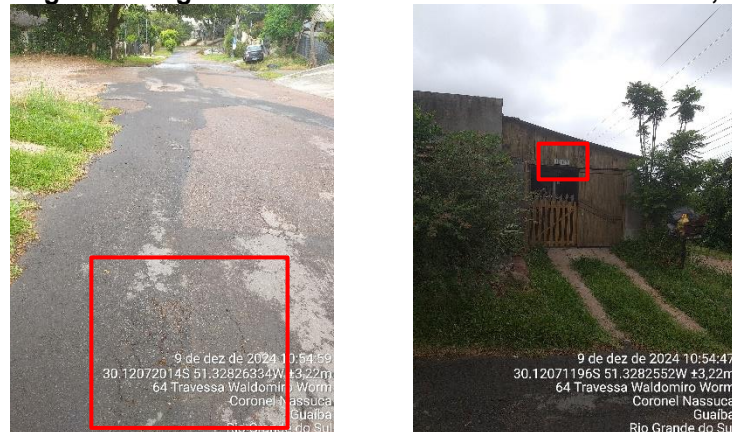
Figura 22 - Registro fotográfico evidência 22 - Rua Júlio Ostrowski, nº 117 a 128
