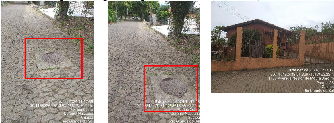
Figura 11 - Registro fotográfico evidência 11 - Rua Ceará, nº 84
