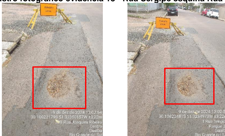
Figura 18 - Registro fotográfico evidência 18 - Rua Sergipe esquina Rua Joaquim Ribeiro
