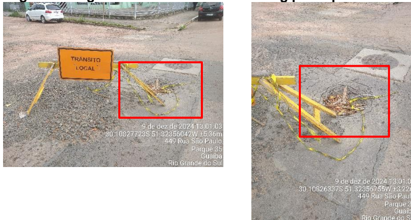
Figura 17 - Registro fotográfico evidência 17 - Rua Sergipe esquina Rua Joaquim Ribeiro
