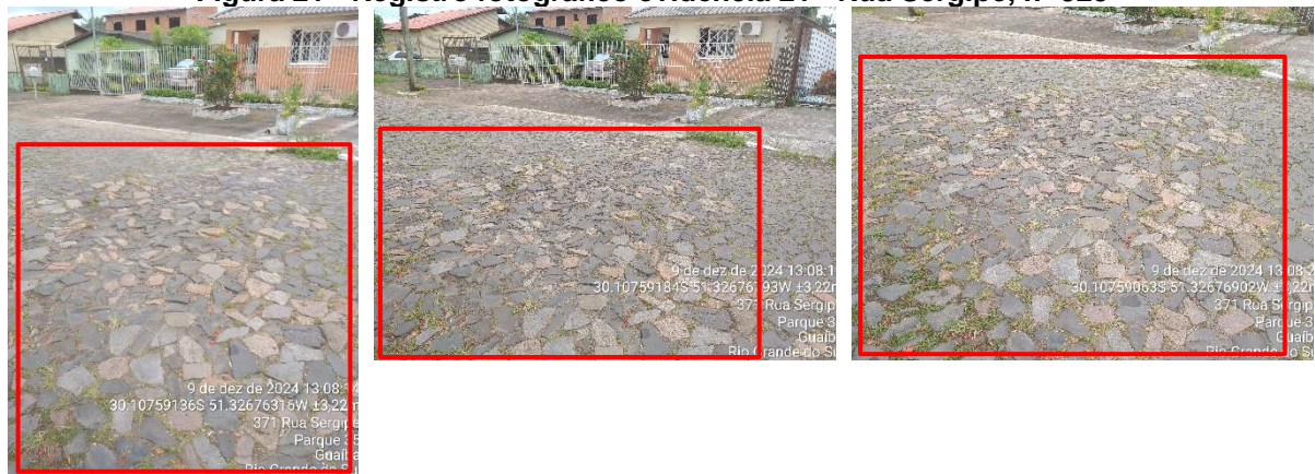
Figura 21 - Registro fotográfico evidência 21 - Rua Sergipe, nº 325
