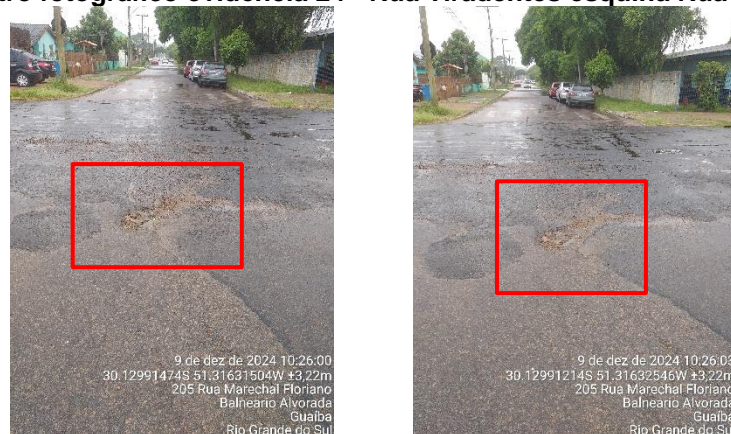
Figura 24 - Registro fotográfico evidência 24 - Rua Tiradentes esquina Rua Marechal Floriano
