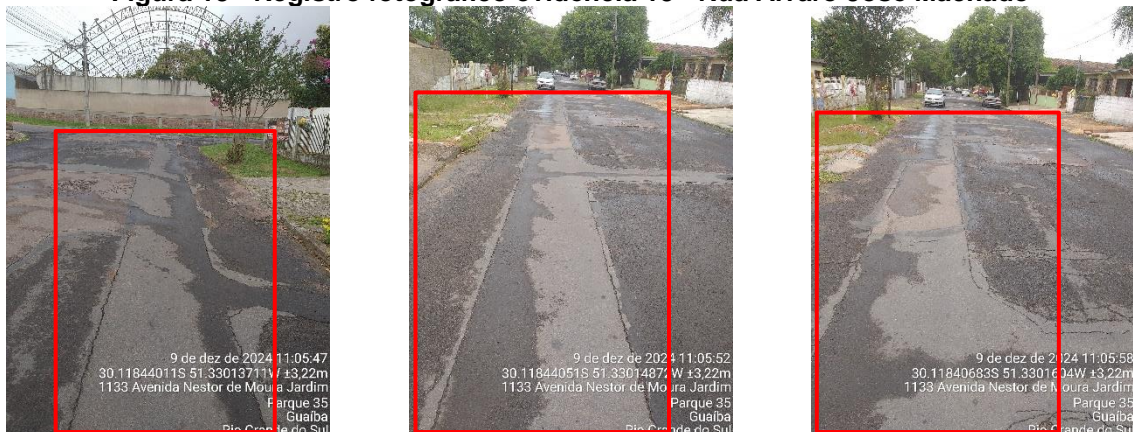
Figura 13 - Registro fotográfico evidência 13 - Rua Álvaro José Machado
