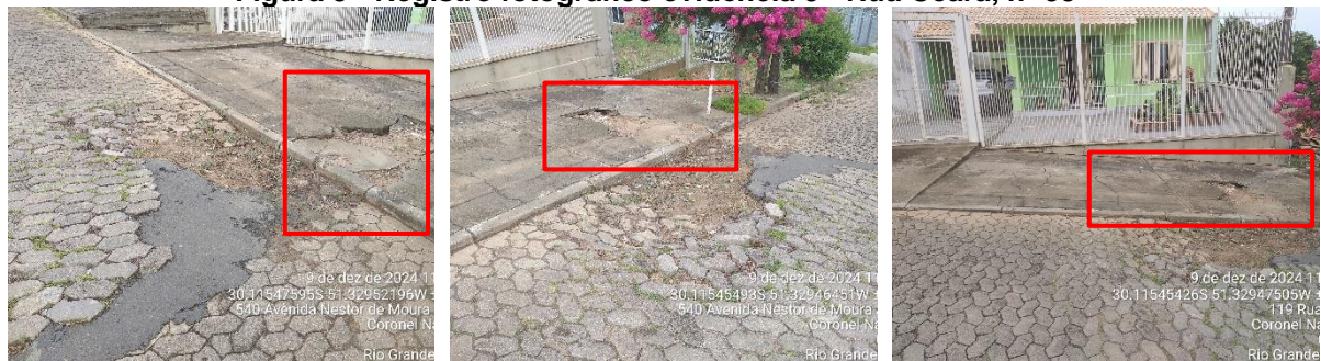
Figura 9 - Registro fotográfico evidência 9 - Rua Ceará, nº 95
