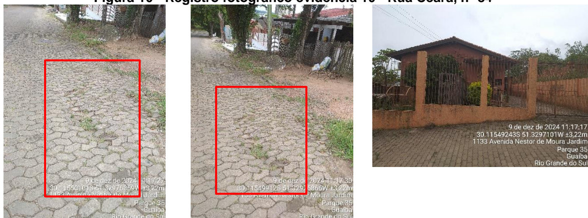
Figura 10 - Registro fotográfico evidência 10 - Rua Ceará, nº 84
