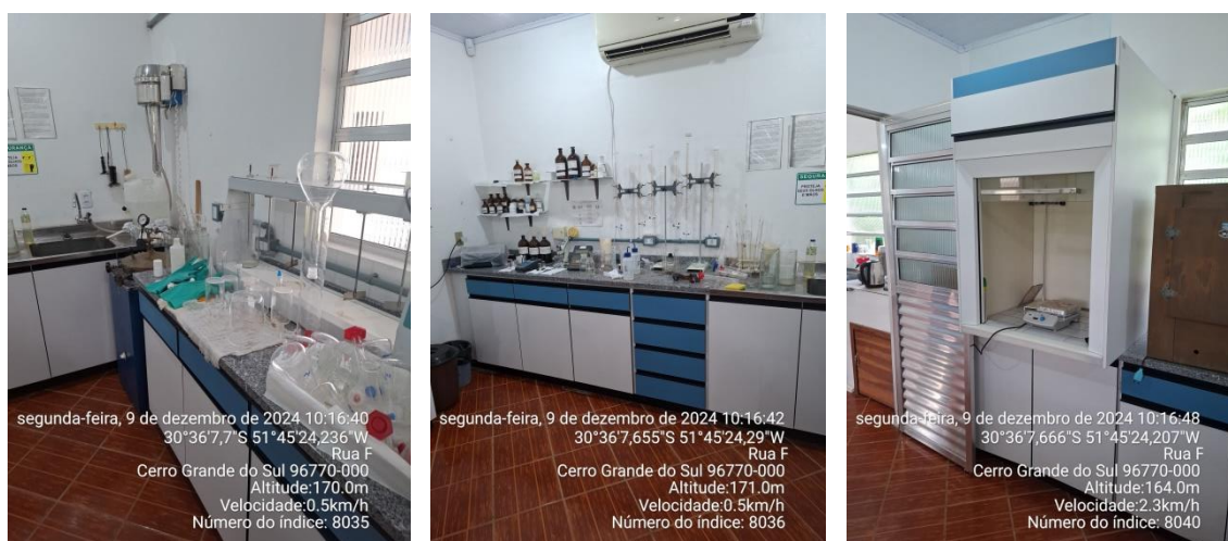
Figura 3: Laboratório Operacional da ETA de Cerro Grande Do Sul.
