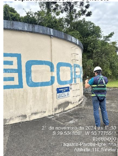
Figura 18 - Reservatório R1B. Capacidade: 200 m 3 - Concreto
