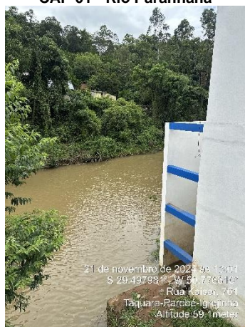
Figura 1 - Captação Superficial CAP 01 - Rio Paranhana
