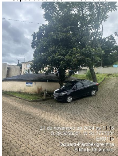
Figura 16 - Reservatório R1. Capacidade: 500 m 3 - Concreto
