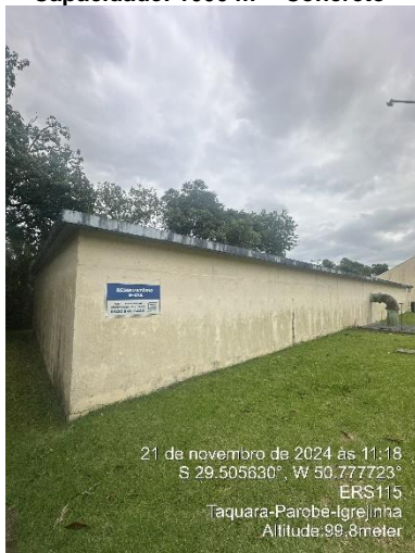
Figura 17 - Reservatório R1A. Capacidade: 1000 m 3 - Concreto
