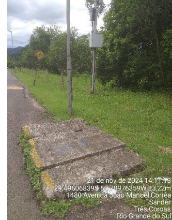
Figura 15 Sistema de Bombeamento EBAT - 12 (Sander).
