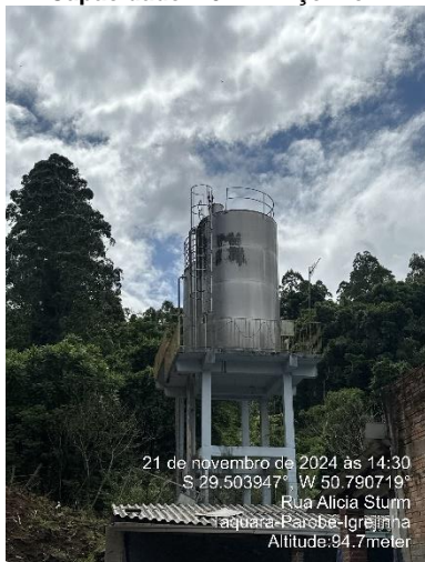
Figura 29 - Reservatório R11A. Capacidade: 20 m 3 - Aço Inox
