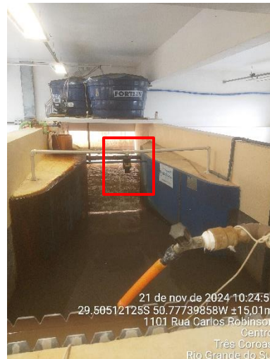
Figura 40 - Macromedidor ETA.
