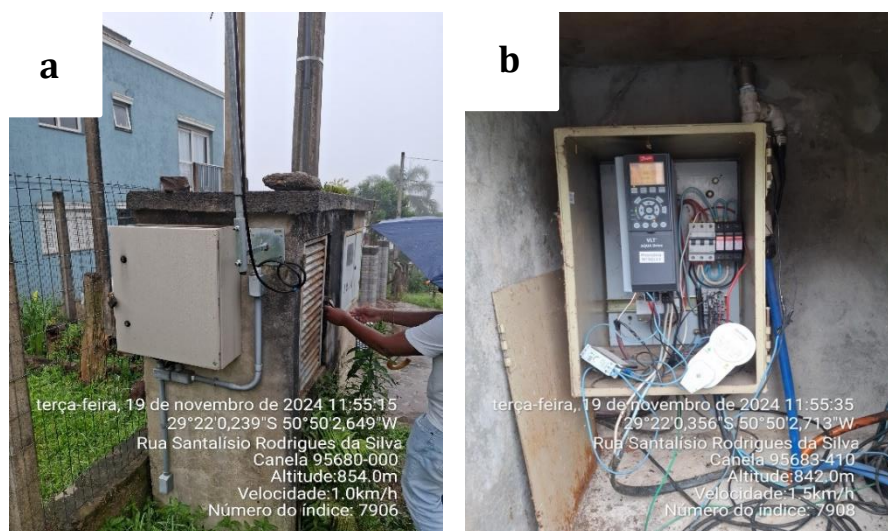
Figura 8: Ponto de controle de pressão instalado na EBAT da ETA I.
