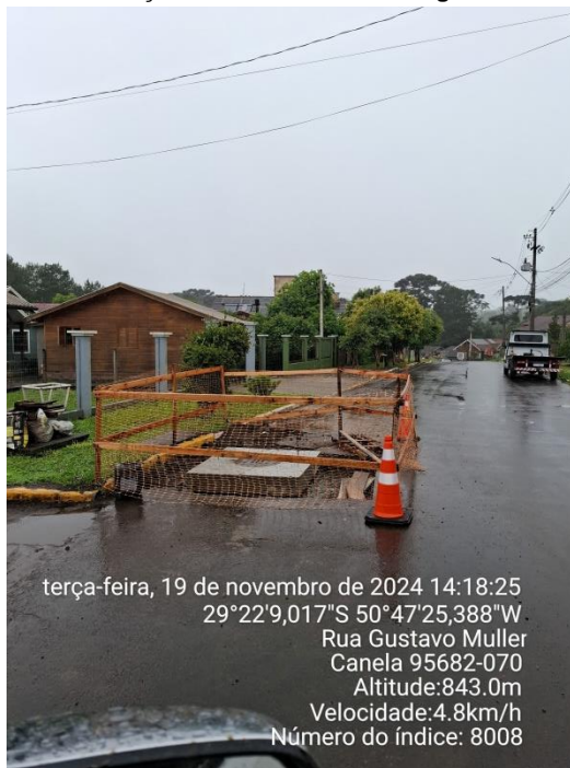
Figura 12: Intervenção na rede coletora de esgoto em Canela/RS.
