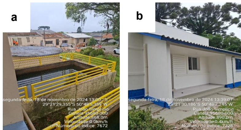
Figura 5: Identificação da ETA I de Canela/RS. a) Vista da área de filtros e obras ao fundo; b) vista frontal da obra de construção do novo laboratório operacional em fase final;
