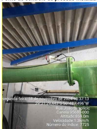
Figura 8: Ponto de controle de pressão instalado na EBAT da ETA I.
