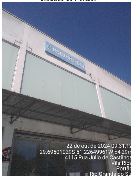
Figura 05 - Unidade comercial. Unidade de Portão.
