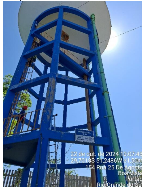
Figura 04 - Reservatório R2. Capacidade: 250 m³ - Concreto Armado
