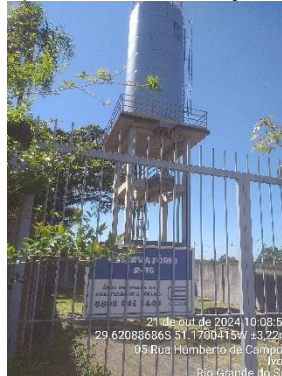
Figura 31 - Reservatório R16. Capacidade: 100 m 3 - Aço Inox
