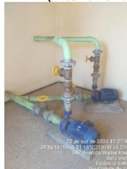
Figura 17 - Sistema de Bombeamento EBAT - 11 (Altos Horizontes).
