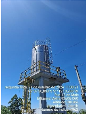
Figura 30 - Reservatório R15. Capacidade: 100 m 3 - Aço Inox
