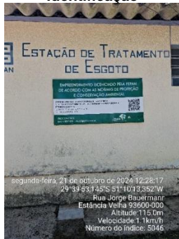
Figura 36 - ETE Nova Estância. Identificação
