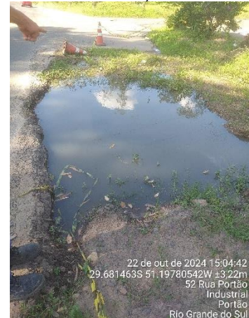
Figura 35 - Macromedidor Rua Portão, nº 52.
