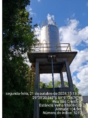
Figura 31 - Reservatório R16. Capacidade: 100 m 3 - Aço Inox
