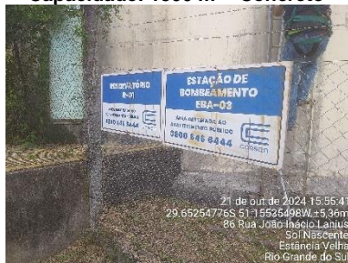
Figura 18 - Reservatório R1. Capacidade: 1500 m³ - Concreto
