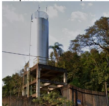
Figura 25 - Reservatório R10. Capacidade: 100 m³ - Aço Inox
