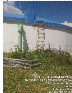
Figura 23 - Reservatório R7. Capacidade: 200 m³ - Concreto
