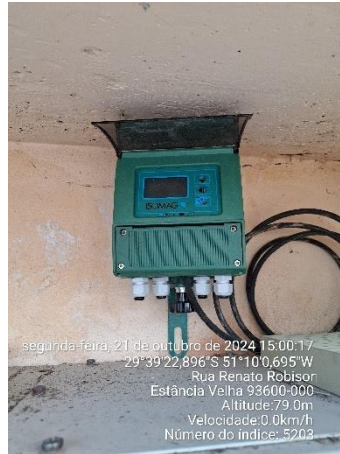
Figura 34 - Macromedidor Junto c/ EBAT - 4.
