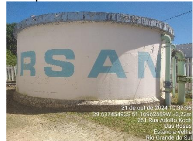
Figura 23 - Reservatório R7. Capacidade: 200 m³ - Concreto
