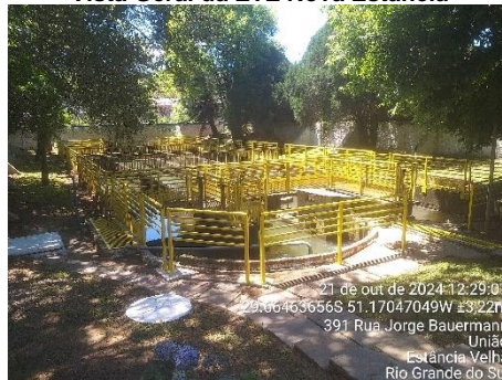
Figura 37 - ETE Nova Estância. Vista Geral da ETE Nova Estância
