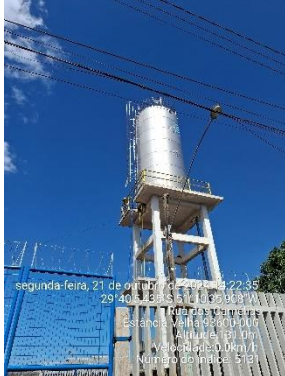
Figura 30 - Reservatório R15. Capacidade: 100 m 3 - Aço Inox
