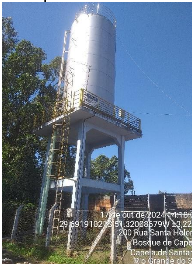
Figura 22 - Reservatório R1 - Escritório Capacidade: 100 m 3 - Inox
