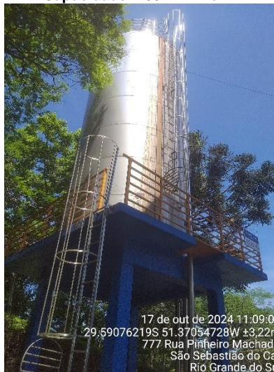
Figura 21 - Reservatório R13 - ETA Capacidade: 100 m 3 - Inox
