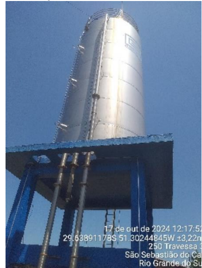
Figura 23 - Reservatório R2 - Praça Capacidade: 50 m 3 - Inox
