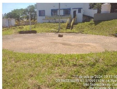
Figura 15 - Reservatório R1 - ETA Capacidade: 500 m³ - Concreto Armado
