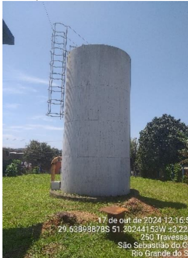
Figura 22 - Reservatório R1 - Escritório Capacidade: 100 m 3 - Inox
