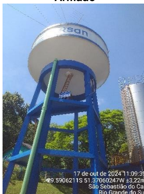
Figura 16 - Reservatório R2 - ETA Capacidade: 100 m³ - Concreto Armado
