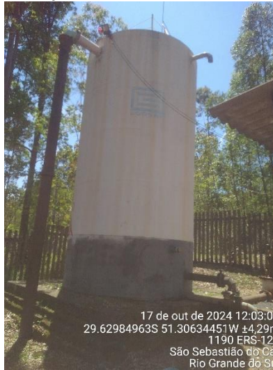
Figura 21 - Reservatório R13 - ETA Capacidade: 100 m 3 - Inox
