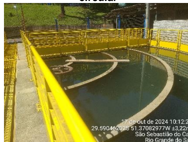
Figura 7 - Decantador convencional circular
