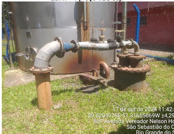
Figura 13 - Sistema de Bombeamento Compacto. EBAT - 4 (Poço VLC 02).
