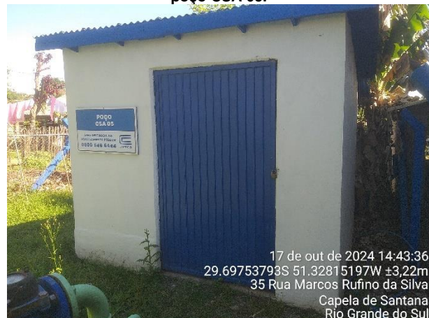
Figura 10 - Exterior da Casa de Química simplificada do poço CSA 05.
