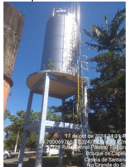
Figura 23 - Reservatório R2 - Praça Capacidade: 50 m 3 - Inox
