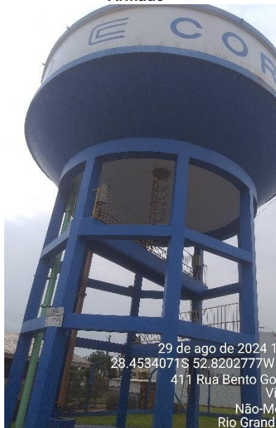
Figura 16 - Reservatório R3 Capacidade: 250 m 3 - Concreto Armado
