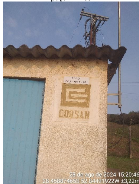
Figura 11 - Exterior da Casa de Química simplificada do poço NMT 09.
