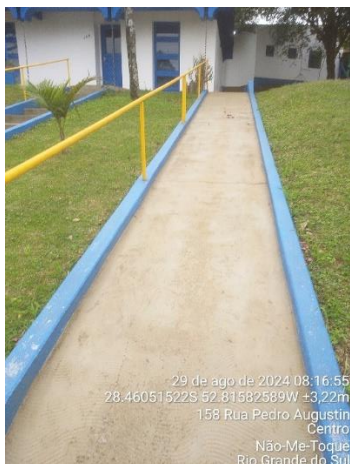
Figura 21 - Unidade comercial. Acessibilidade da Unidade de Não-Me-Toque.
