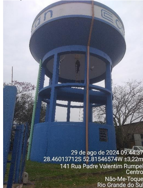
Figura 15 - Reservatório R2 Capacidade: 250 m 3 - Concreto Armado
