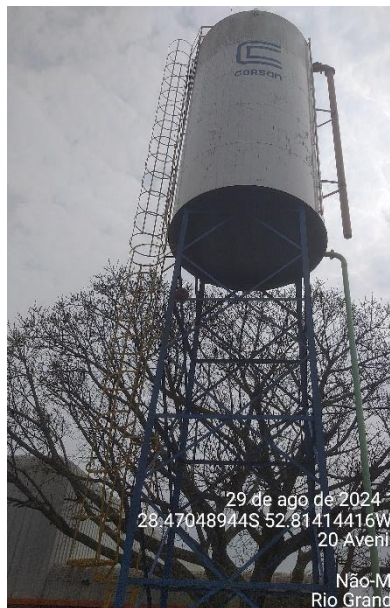
Figura 17 - Reservatório R4 Capacidade: 50 m 3 - Metálico
