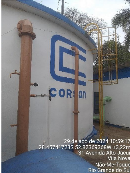
Figura 16 - Reservatório R3 Capacidade: 250 m 3 - Concreto Armado
