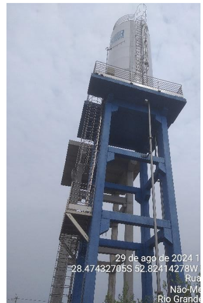
Figura 18 - Reservatório R5 Capacidade: 70 m 3 - Inox
