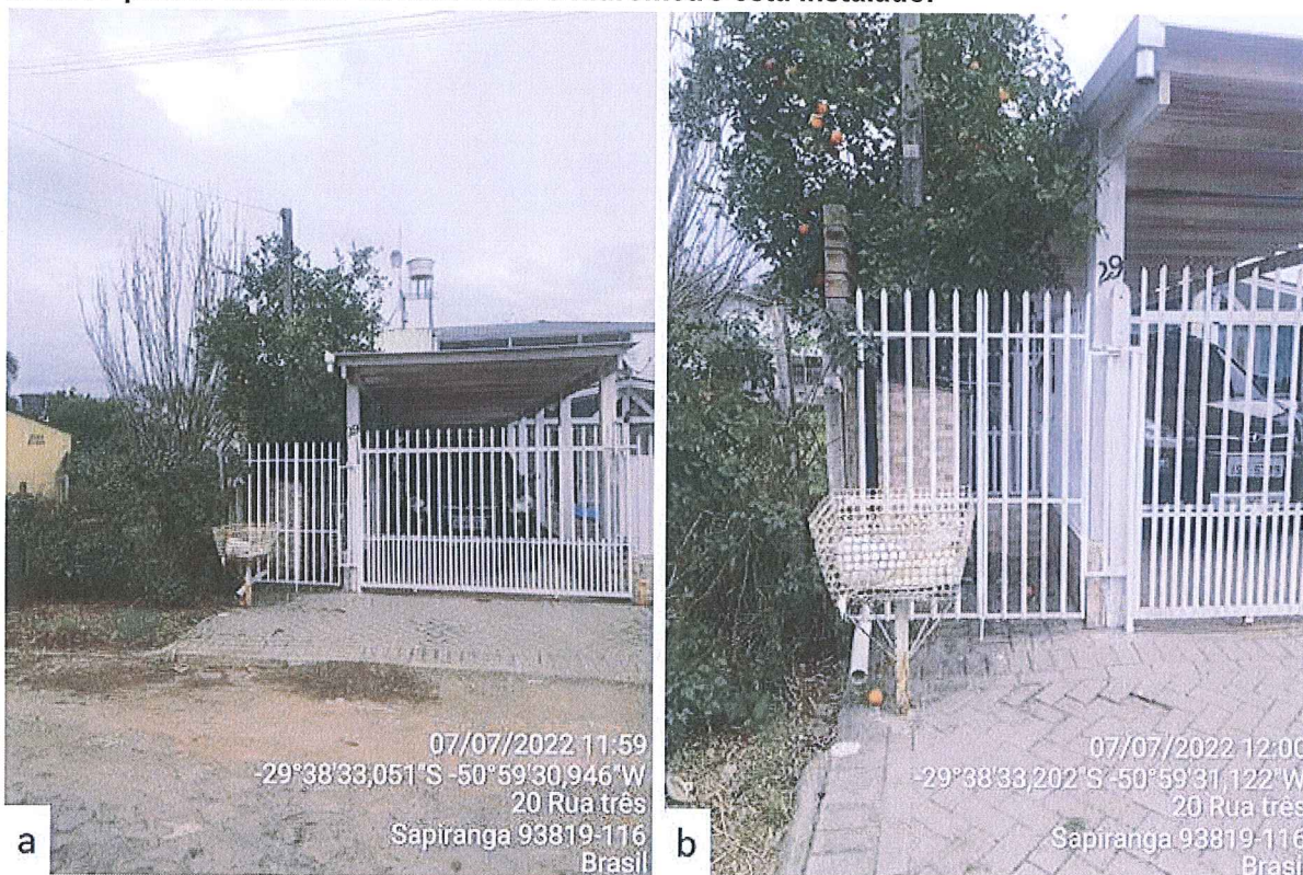
Figura 3 - Registro fotográfico da fachada do imóvel: a) Vista geral da fachada do imóvel; b) Vista do novo portão instalado na área onde o hidrômetro está instalado.
