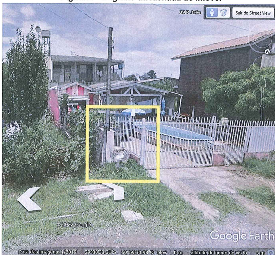
Figura 2 – Registro da fachada do imóvel
